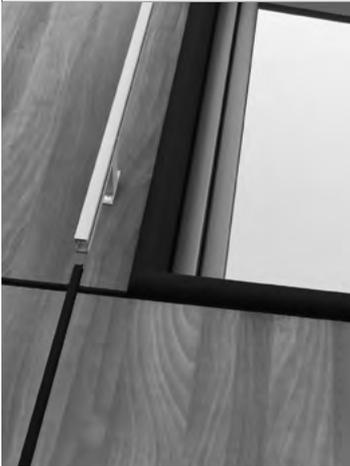
Clip-Keder in die Führungsschiene einschieben und die Führungszapfen der Raffstorelamellen einfädeln. Anschließend die Endkappe als Abschluss der Führungsschiene montieren.
