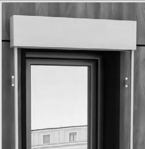
Vorsatzschacht auf Führungsschienen aufstecken.
