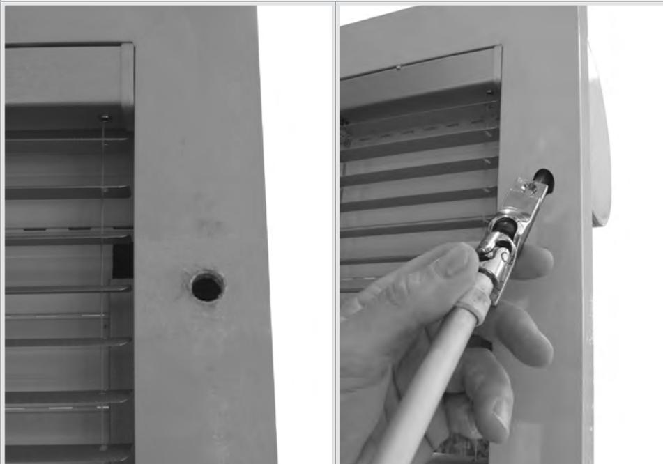
Befestigen Sie die Kurbeldurchführung am Fensterrahmen. Schrauben Sie nun den Kurbelhalter so an den Fensterrahmen, dass die Kurbelstange lotrecht am Fensterrahmen anliegt.
