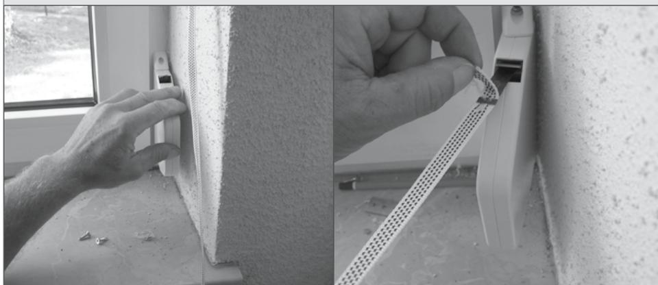
Schrauben Sie den Gurtwickler an den Fensterstock an. Stecken Sie den Gurt in den Gurtspanner und lösen Sie die Verankerung. Gurt langsam aufwickeln lassen.
