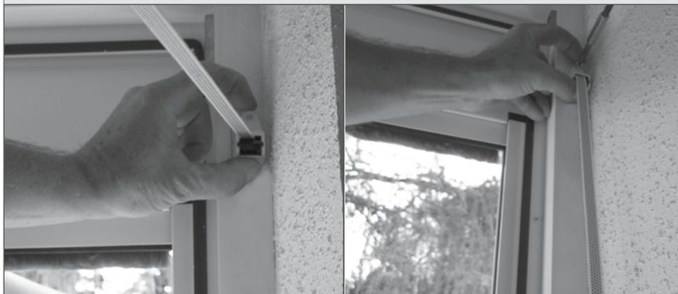
Führen Sie zunächst den Gurt, wie in der Abbildung, durch die Umlenkrolle. Anschließend schrauben Sie die Umlenkrolle auf die Bohrung in den Fensterrahmen.
