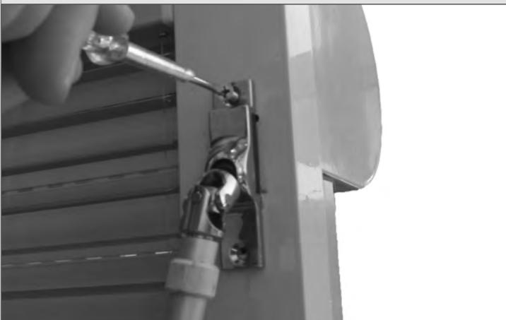
Gelenklagerplatte mit zwei Schrauben befestigen.
